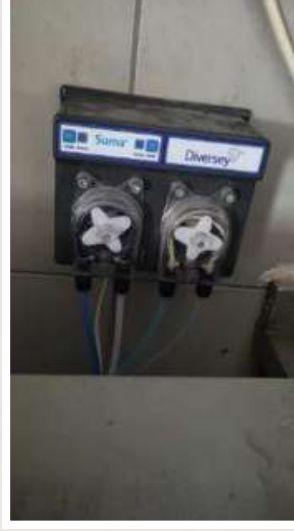
Bar Bulaşık Makineleri Dozajlama Sistemi
